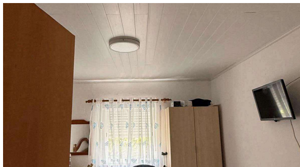
Depois da intervenção
