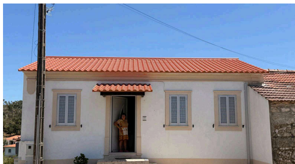
Depois da intervenção
